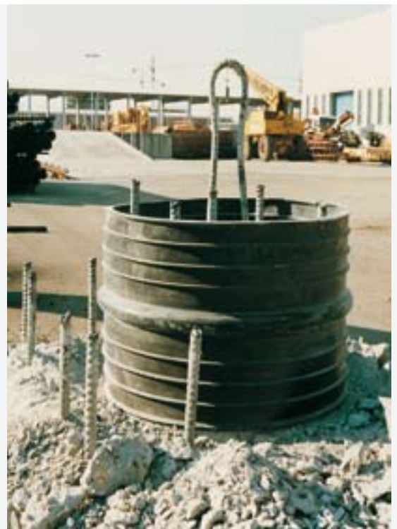
Giunto di ripresa Waterstop PVC Flexvinil® tipo SA per posa esterna Construction joint SA Flexvinil® PVC Waterstop placed externally Joint de reprise Waterstop PVC Flexvinil® type SA pour la pose à l'extérieur Junta de reanudación Watertop PVC Flexvinil® tipo SA por pose exterior
